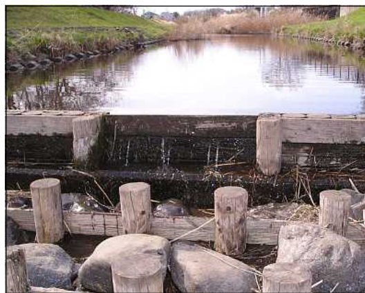
やまべ橋下から下流を望む (平成 29 年 3 月 24 日) 堰の様子 (堰止め隙間から水が流れている)
