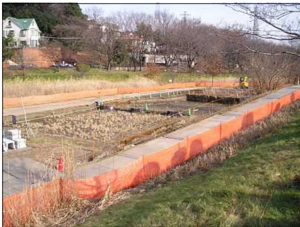
⑫第2田んぼの工事（2016年2月）
