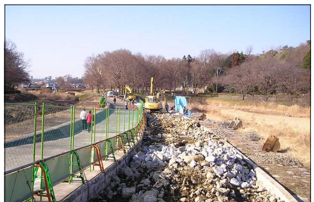
⑧ 越流堤緑化工事
