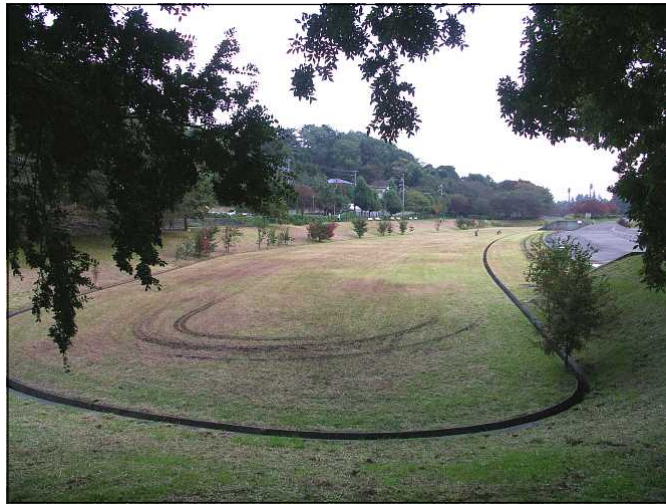
自然再生工事前（第一調節池西側からのぞむ）
