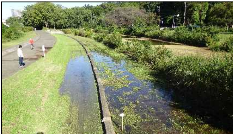
第一調節池の越流堤 左；野川側 右：調節池
